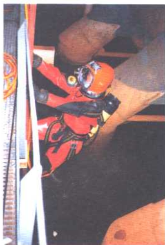
Operación de mantenimiento en la central nuclear de Garoña
