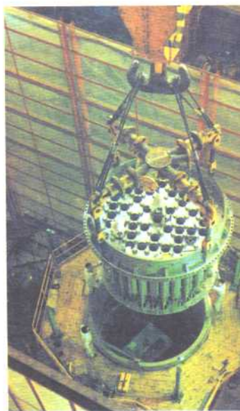
Detalle de los componentes internos de la parte superior de una vasija
